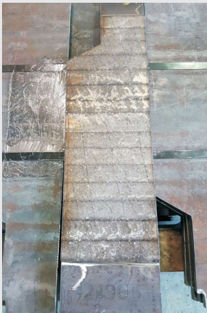
Zbrojenia młynów węgla Armaments coal mills
